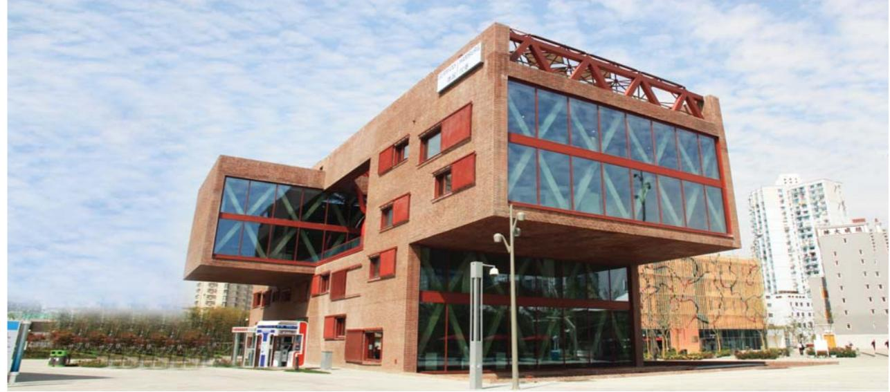
凡士能墙体系统为上海世博园德国汉堡城市案例馆“汉堡之家”提供了墙体系统解决方案，极大限度地提高了建筑保温隔热性能，使建筑物对采暖和制冷的需求降到最低。“汉堡之家”也是中国境内第一个获得认证的被动式房屋建筑。
