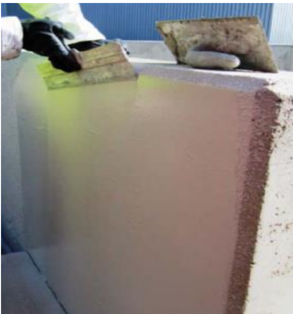
Bild 3: slutförande av MasterSeal 6100 FX applicering
