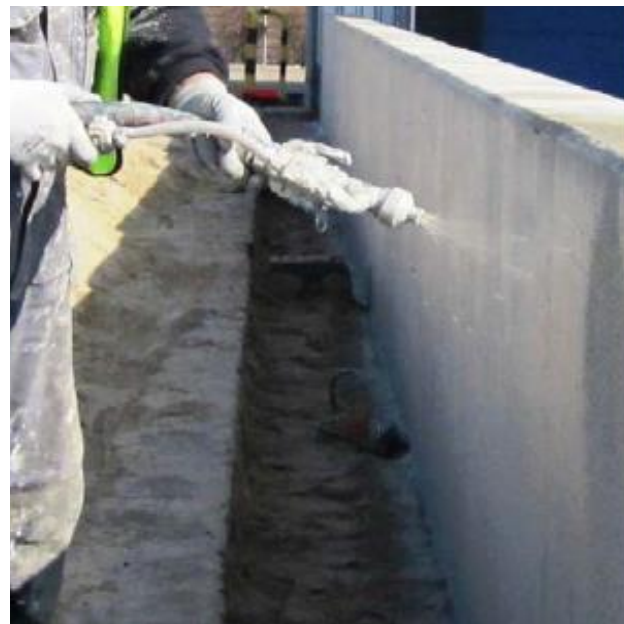
Bild 2: Applicering av MasterSeal 6100 FX genom sprutning
