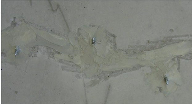
Figur 1. Nipplar med sockel placerade runt sprickan och förseglade med lämpligt epoxilim ur MasterBrace-serien.
