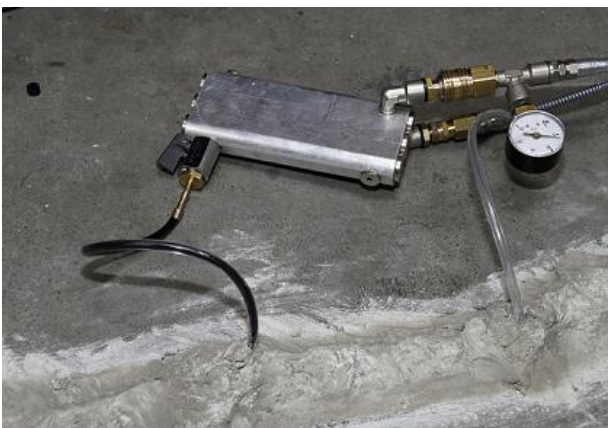
Figur 3. Injektering av MasterInject 1380 med en tvåkomponentpump för reparation av ett betonggol.
