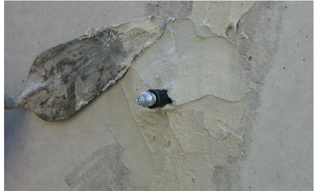
Figur 2. Försegla de ytmonterade nipplarna med MasterFlow 920 AN.
