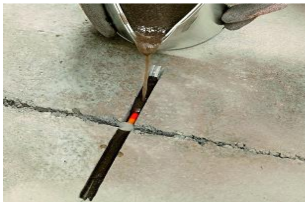
Figur 6. Fyllning av ankarskårorna och sprickorna med MasterInject 1360-blandning.
