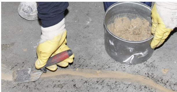
Figur 5. Utjämning av sprickytan med lämpligt MasterBrace-bruk.
