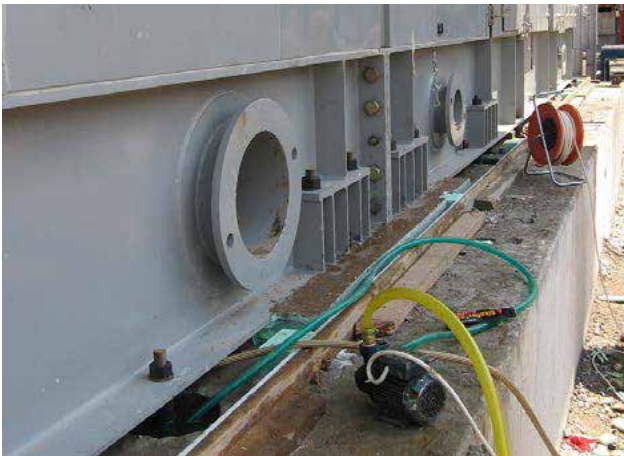
Figur 1. Mätta och dränera överflödigt vatten i turbinfundamentets ankarhål före injektering.
