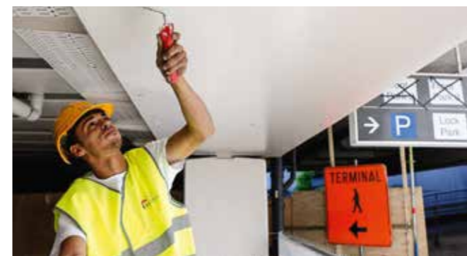
Manuell påföring av MasterProtect 330 EL (parkeringsanläggning på Bryssels flygplats i Belgien)
