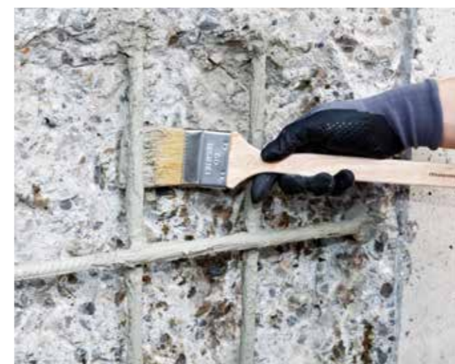
Påföring av MasterEmaco P 5000 AP på rengjord armering
