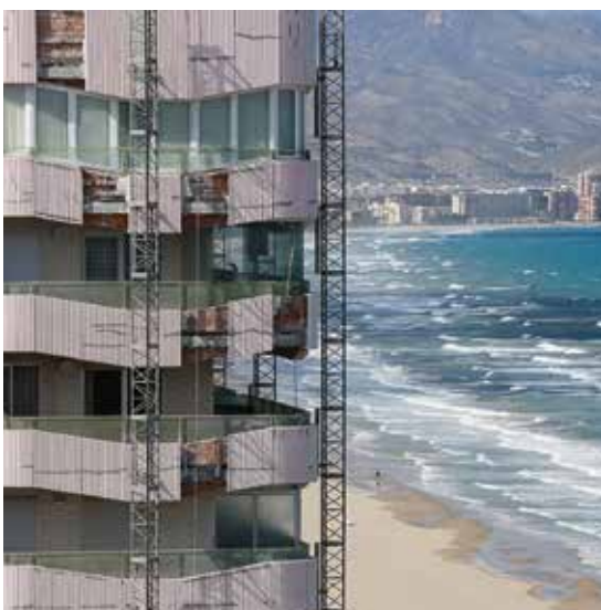
Princip 1: Skydd mot kloridangrepp. Torres Blancas, Alicante, Spanien: Skydd med korrosionsinhibitorer MasterProtect 8000 CI.
