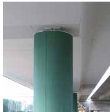
Princip 9, metod 9.1 MasterProtect: Ytbehandling påförs direkt på betongen för att skydda den underliggande armeringen.
