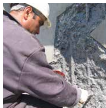
Princip 11, metod 11.1 MasterEmaco Aktivt korrosionsskydd av armeringen.
