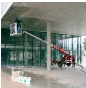
Princip 8, metod 8.1 MasterProtect Vattentätande behandling .
