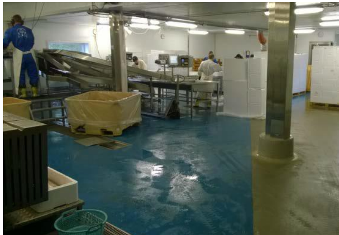
Ytbeläggning av produktionsanläggningens golv
