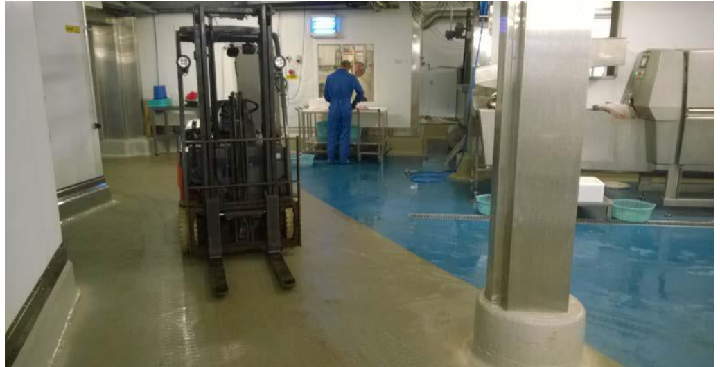
Ytbeläggning av produktionsanläggningens golv
