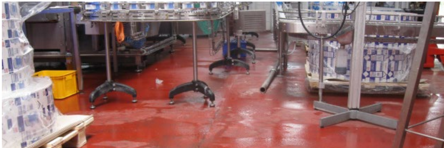
Vysokoodolné podlahové systémy Ucrete vo výrobnom závode
