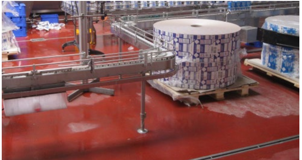
Vysokoodolné podlahové systémy Ucrete vo výrobnom závode
