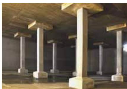
Hydroizolácie nádrží na pitnú vodu (vodojemy)
