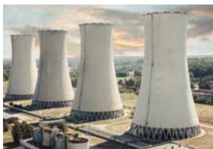
Ochrana a hydroizolácia chladiacich veží
