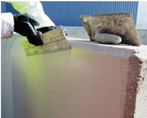
Obr. 3: Finálna úprava povrchu MasterSeal 6100 FX.
