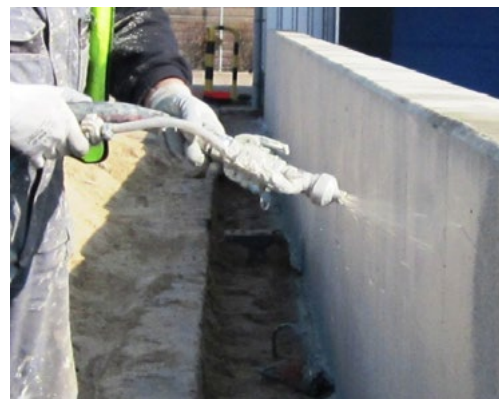
Obr. 2: Aplikácia MasterSeal 6100 FX nástrekom.
