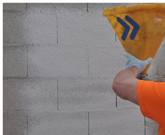
Obr. 2: Aplikácia MasterSeal 560 striekaním
