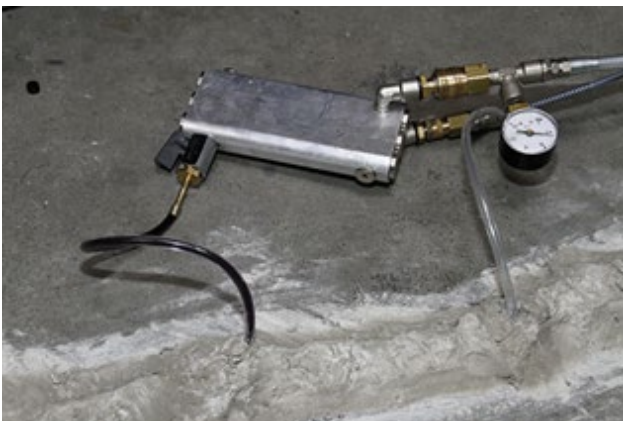
Obr. 3. Oprava betónovej podlahy injektážou s MasterInject 1380 dvojzložkovým injektážnym prístrojom.
