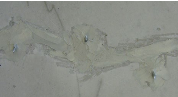
Obr. 1. Injektážne pake umiestnené okolo trhliny a zatmelené vhodným epoxidovým lepidlom.
