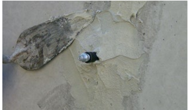
Obr. 2. Utesnenie pakra lepeného na povrch trhliny s MasterFlow 920 AN.
