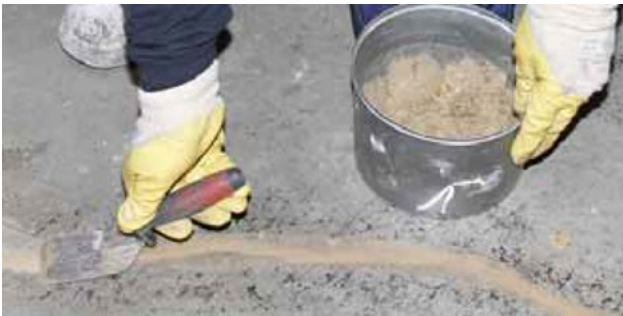
Obr. 5 Vyrovnanie povrchu škáry vhodnou maltou MasterBrace.
