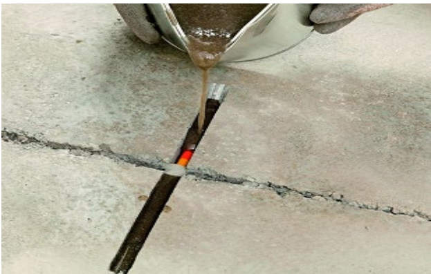
Obr. 6 Vypĺňanie kanálikov s poterovými svorkami a trhlín zmesou MasterInject 1360
