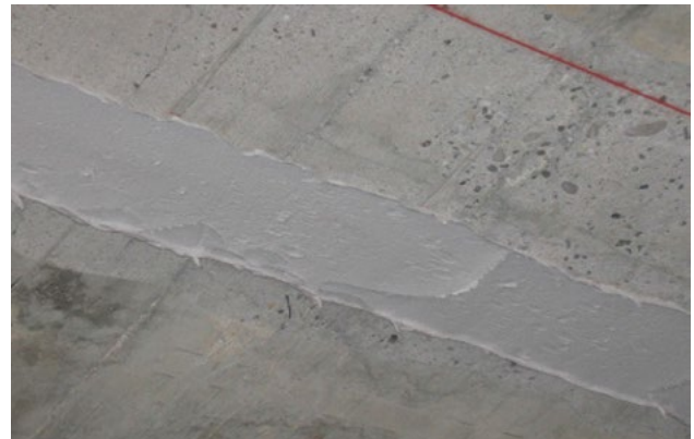
Obr. 2 MasterBrace ADH 4000 sa nanáša na betónový podklad oceľovou špachtľou.
