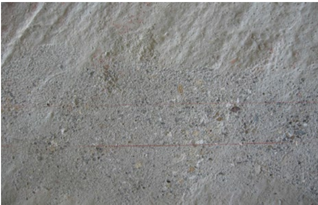
Obr. 1 Zbrúsený povrchu betónu pred aplikáciou lepidla.
