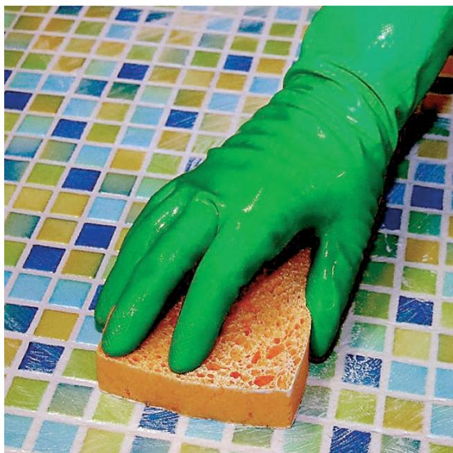
Мытье затертого покрытия мягкой эпоксидной губкой PCI
