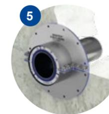
5 Установка герметизирующих прокладок между верхней и нижней частью **MasterSeal 991** и окончательное закрепление верхней части фланца **MasterSeal 991**
