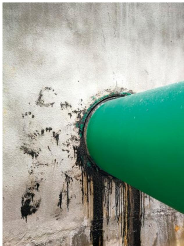
Зоны проходов коммуникаций через строительные конструкции – одни из таких «слабых мест» сооружений. Отверстия под коммуникации, как правило, имеют большое сечение, как итог, зазор между трубой или кабельной проходкой не всегда поддаётся качественной и надёжной гидроизоляции. Порой в ход идут просмоленная каболка, пенополиуретан, цементно-песчаные смеси. Итог – протечки, выход из строя коммуникаций, испорченное имущество в помещениях, разрушение строительных конструкций.
