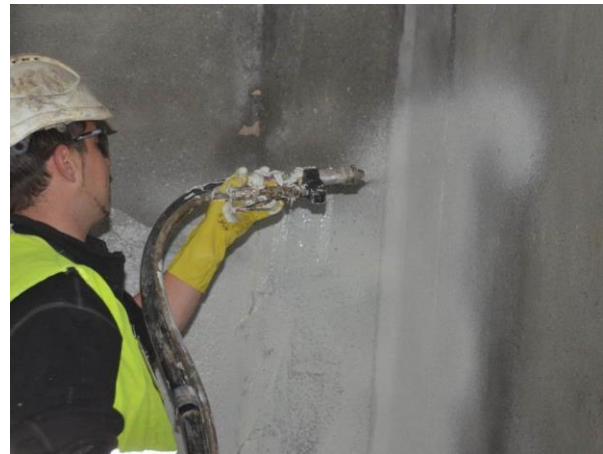
Нанесение состава MasterSeal P 385 пневматическим распылителем
