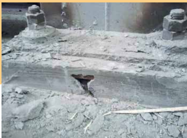
Неполное заполнение (необходимо дополнительное инъецирование пустот)
