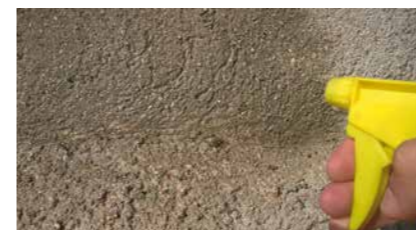
Antes de aplicar a argamassa estética, humedecer o suporte sem o encharcar (húmido, mas mate)
