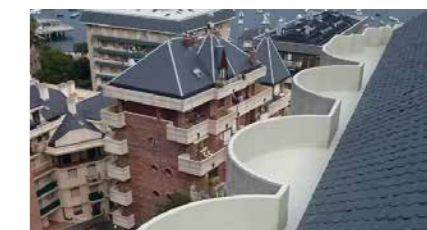
Sela-se a membrana de impermeabilização com MasterSeal M 251 pigmentada ou transparente.
