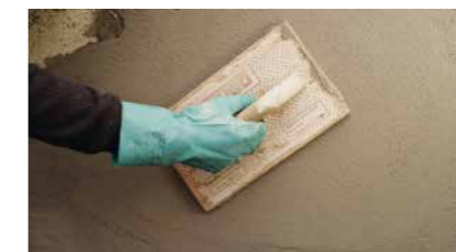
Aplicar a argamassa de reparação estética MasterEmaco N com talocha, espátula, por projeção ou por vertido.
