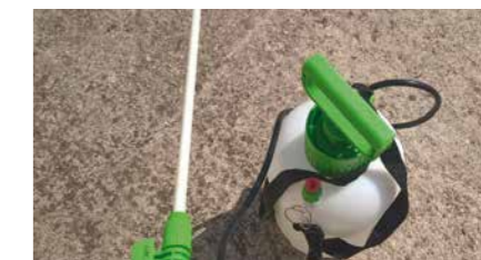
Antes da aplicação da argamassa de presa ultrarrápida, humedecer o suporte com água sem encharcar
