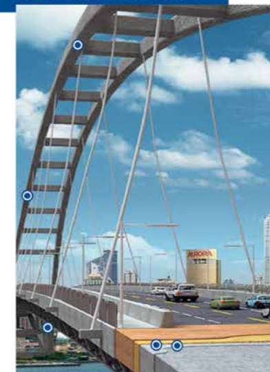
Infraestrutura / Obra civil
