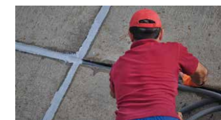
Tratamento e selagem das juntas com MasterSeal NP (ver pág. 32 e 34)
