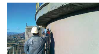
Aplicação do MasterProtect 320/325 EL por projeção com airless.
