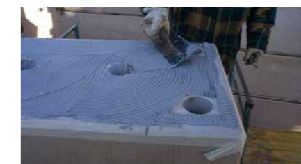
Aplicação do adesivo epóxi com espátula no suporte.
