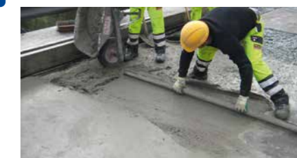
Aplicar o MasterEmaco T 1400 FR sobre o pavimento de betão.
