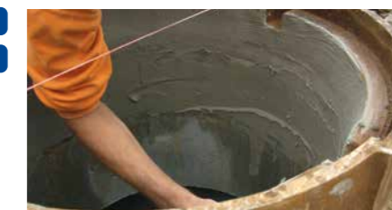
Aplicar o MasterEmaco T 1100 TIX com talocha ou espátula
