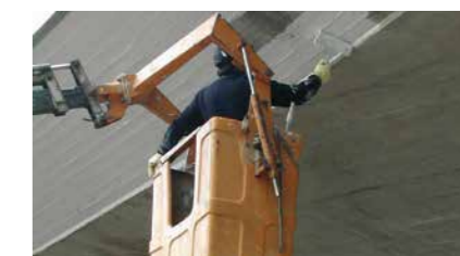
Aplicação do MasterProtect 320/325 EL com rolo.
