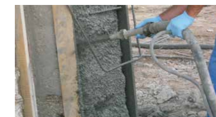
Aplicar a argamassa de reparação MasterEmaco S/N com talocha, espátula, por projeção ou por vertido. Ver sistemas de reparação de betão nas páginas 10, 14.
