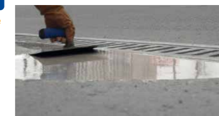
Nivelar o MasterEmaco T 1200 PG sobre o suporte humedecido
