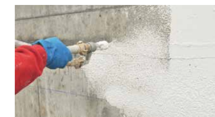
Aplicação de argamassa de impermeabilização MasterSeal por projeção, trincha ou com talocha.
