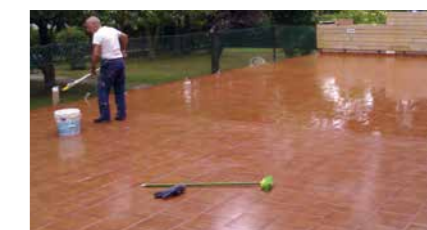
Aplica-se a membrana de impermeabilização MasterSeal M 251 pigmentada ou transparente com rolo de pelo curto.
