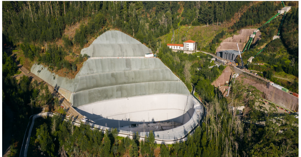
Impermeabilização do depósito na Central Hidroelétrica da Calheta (Madeira).
