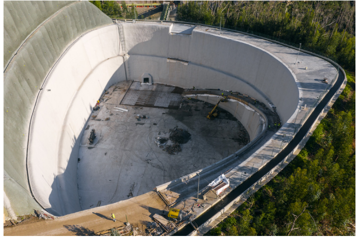
Regularização de paramentos com argamassa de módulo médio MasterEmaco S 5300 e impermeabilização com membrana de elevadas prestações MasterSeal 6100 FX
