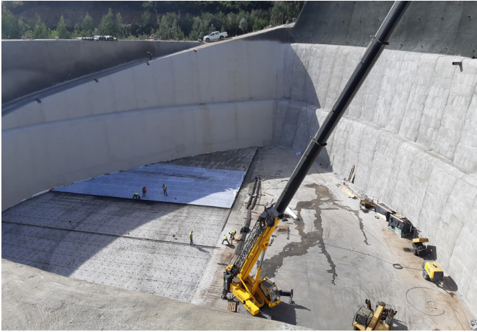
Regularização de paramentos com argamassa de módulo médio MasterEmaco S 5300 e impermeabilização com membrana de elevadas prestações MasterSeal 6100 FX
