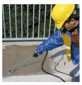
(c) Aplicação: A impregnação deve realizar-se com pincel ou rolo em superfícies pequenas e com pistola ou por outro meio em superfícies de grande extensão. O MasterProtect H 305 é normalmente aplicado numa única camada.
