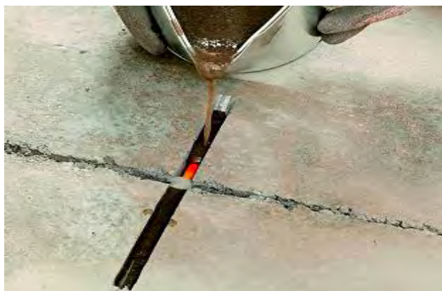
Rys. 6. Wypełnianie kanalików pod ściągą i pęknięć mieszką MasterInject 1360.
