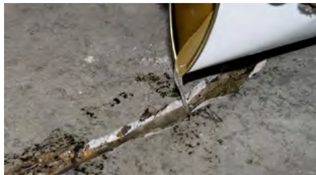
Rys. 4. Wylewanie MasterInject 1360 bezpośrednio w otwartą bruzdę w kształcie litery V w pęknięciu
