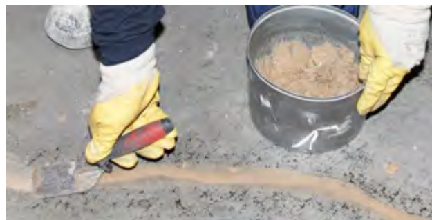
Rys. 5. Wyrównywanie spękaną powierzchnię przy pomocy odpowiedniej zaprawy MasterBrace.
