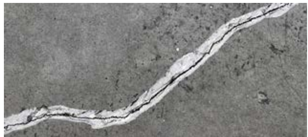
Figur 3. Revneåbningen skåret op i V-formet rille.
