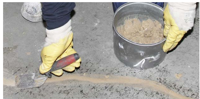
Figur 6. Udjævning af revneoverfladen ved hjælp af den korrekte MasterEmaco-mørtel.
