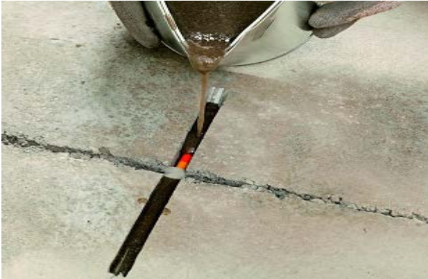
Figur 7. Fyldning af ankerrillerne med MasterInject 1360-blanding.
