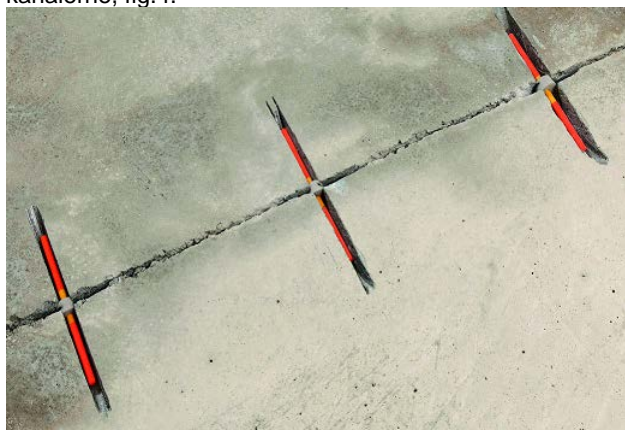
Figur 4. Placering af ankre i de riller, der er lavet i revnerne.
