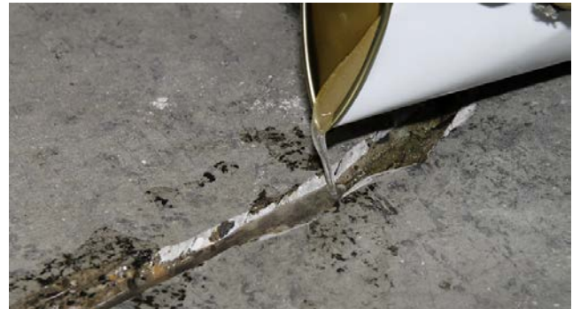
Figur 5. MasterInject 1360 hældes direkte i den V-formede rille, der er skåret i revnen.
