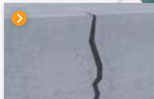
Reparasjoner av undersider samt vertikalt og horisontalt
