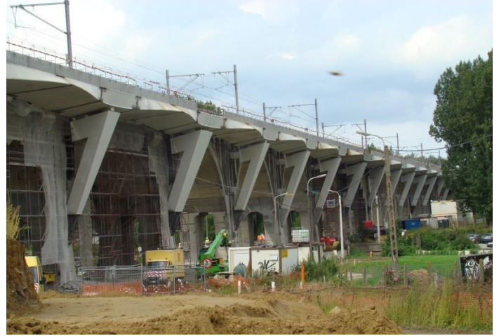
Onze referentie in Dilbeek (België): Viaduct Dilbeek
