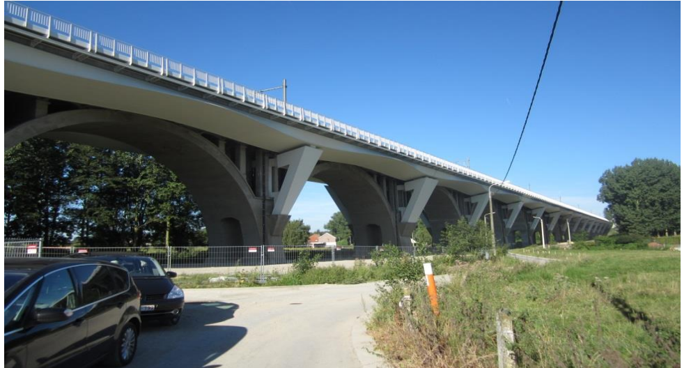
Onze referentie in Dilbeek (België): Viaduct Dilbeek
