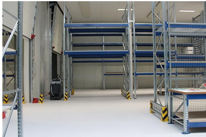
Onze referentie in Maarssen (Nederland): Opslagruimten Paint&Non-Paint artikelen
