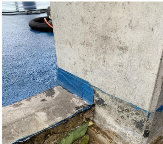
Slopen bestaande opbouw
