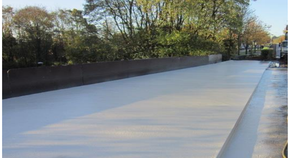
Onze referentie in Leuven (België): Viaduct Leuven
