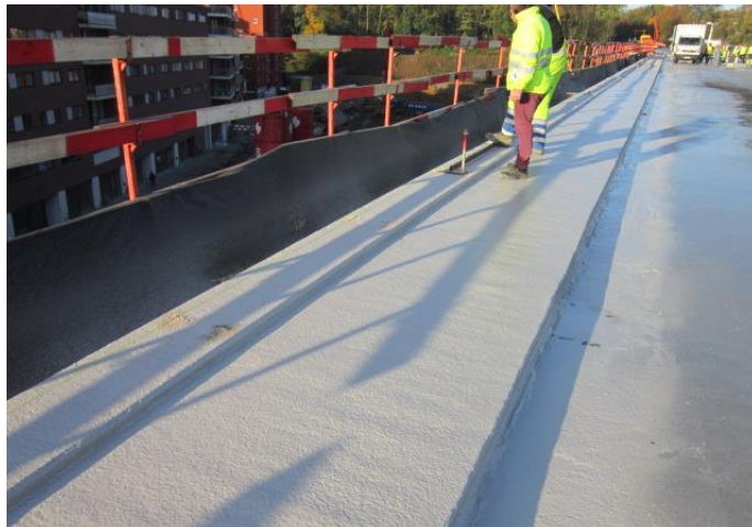
Onze referentie in Leuven (België): Viaduct Leuven
