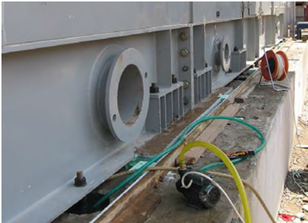
Figuur 1. Verzadiging en afwatering van het overtollige water in de verankeringsgaten van de turbinefundering vóór de aangieting.
