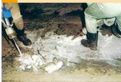
2 劣化コンクリートの除去
