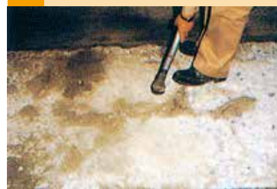
3 打設部分の清掃
