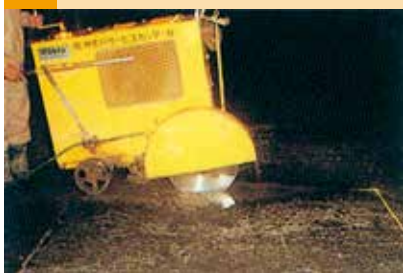
1 劣化コンクリートのカッティング
