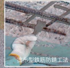
塗布型鉄筋防錆工法
