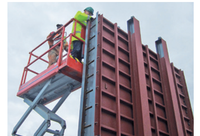
外部の専門家がグラウト施工したモックアップを検査
