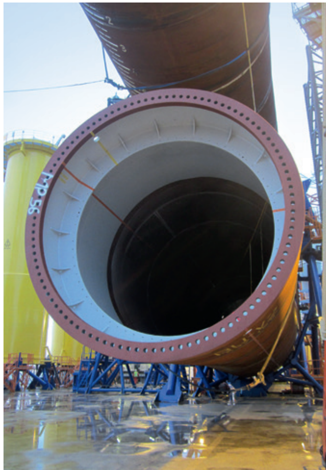
デッキ上モノパイル
