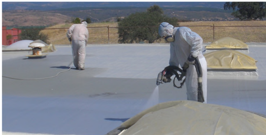
La nostra referenza a Cáceres (Spagna): CETARSA, Impermeabilizzazione del tetto dello stabilimento
