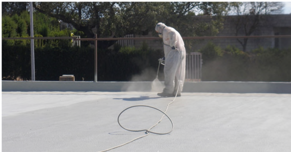
La nostra referenza a Cáceres (Spagna): CETARSA, Impermeabilizzazione del tetto dello stabilimento
