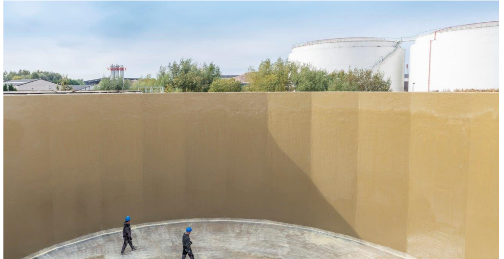
Notre référence à Roulers (Belgique): Zoutman nv, revêtement d'un réservoir de stockage de saumure
