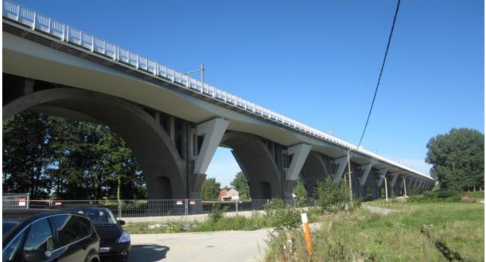
Notre référence à Dilbeek (Belgique): Viaduc de Dilbeek
