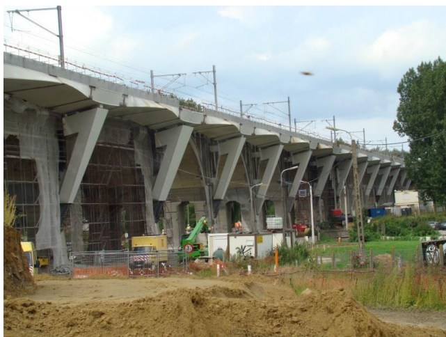
Notre référence à Dilbeek (Belgique): Viaduc de Dilbeek
