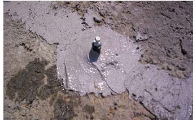
Figure 2: boucher le support d'injecteurs en applique et la fissure avec un produit d'accrochage approprié de la gamme MasterInject.
