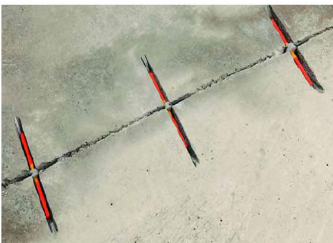
Figure 4: placement des agrafes pour chapes dans les canaux entaillées dans les fissures.
