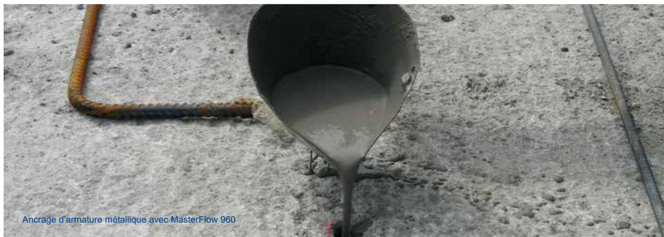
Ancrage d'armature métallique avec MasterFlow 960
