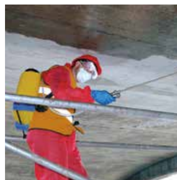
Periaate 9, menetelmä 9.1 Vahvikkeen katodialueen korrosio estetään käyttämällä MasterProtect -korrosionestoaineita.
