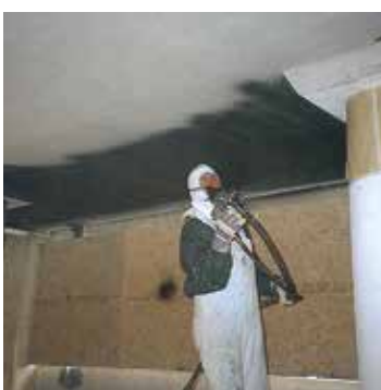
Periaate 10, menetelmä 10.1 MasterProtect CP -pinoitteet suojaavat vahvistettua betonia juurikaan kuormitusta lisäämättä.
