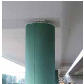
Periaate 9, menetelmä 9.1 MasterProtect -pinoitteet suoraan betonille levitettynä suojaavat betonin sisäisiä vahvikkeita.
