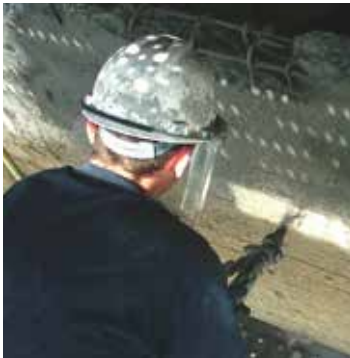
Periaate 7, menetelmä 7.1 Vahvikkeen pinoittaminen ruiskuttamalla MasterEmacoa .
