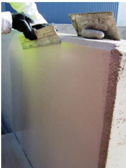
Kuva 2: MasterSeal 6100 FX:n levityksen viimeistely
