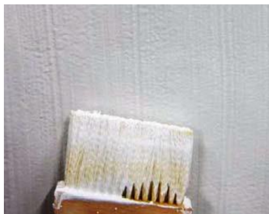
Kuva 1 : Levitys siveltimellä
