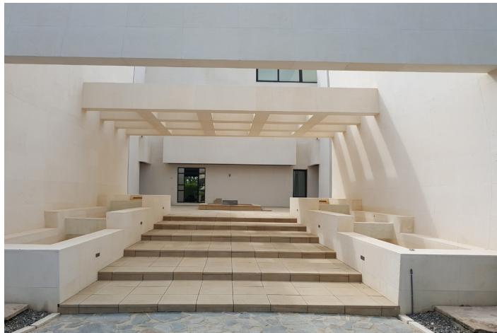
Hormigón hidrofugado con MasterProtect H 305 y aspecto final de la fachada tratada
