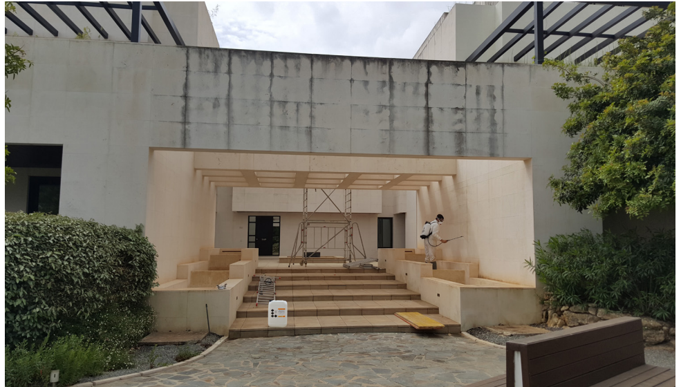
Aplicación de hidrofugante superficial MasterProtect H 305
