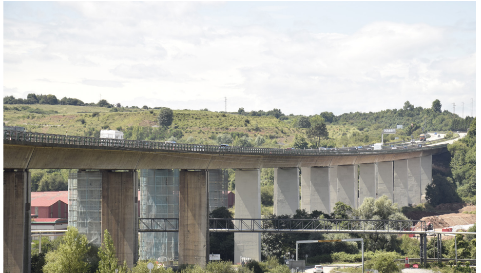
Reparación y protección integral de las pilas del viaducto de Somonte en Gijón (Asturias)
