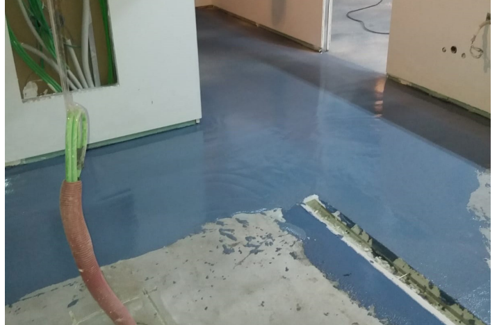
Detalle de distintas fases de la actuación.
