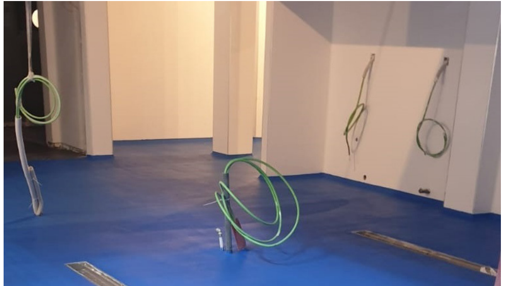
Vista del revestimiento Ucrete del pavimento terminado
