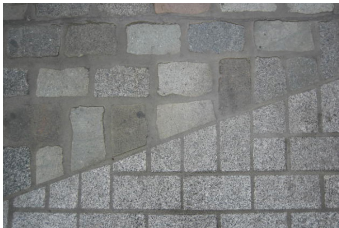
Ejemplo de los adoquines a rejuntar
