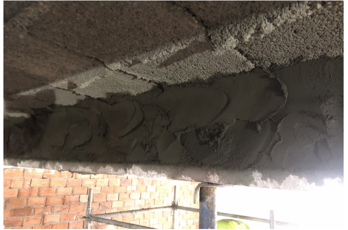
Aplicación de mortero de reparación R3 de módulo medio, con inhibidor de corrosión, para reparación de estructura de hormigón de resistencias medias
