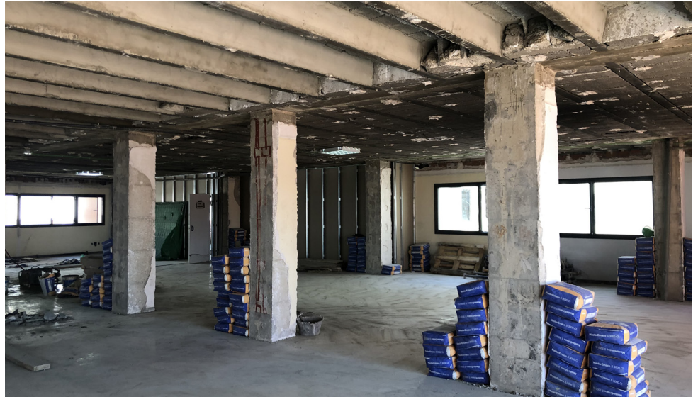
Rehabilitación de viguetas de forjado de hormigón de resistencias medias en estructura de edificio en Sevilla
