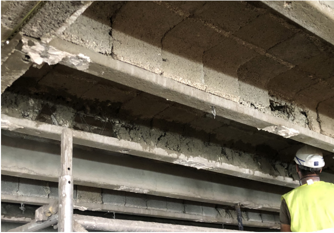
Aplicación de mortero de reparación R3 de módulo medio, con inhibidor de corrosión, para reparación de estructura de hormigón de resistencias medias
