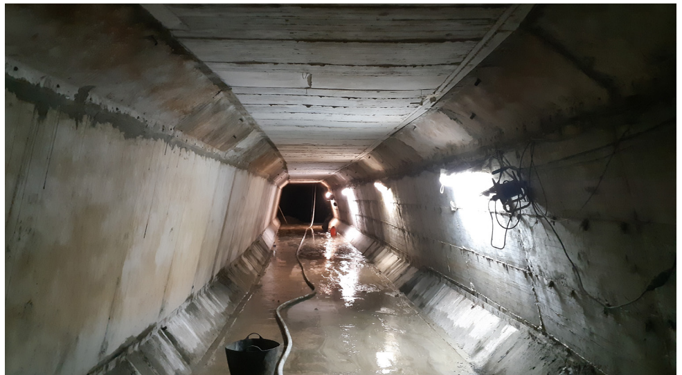
Vista interior del encauzamiento del arroyo
