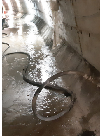
Bombeo del mortero MasterEmaco S 5450 PG.
