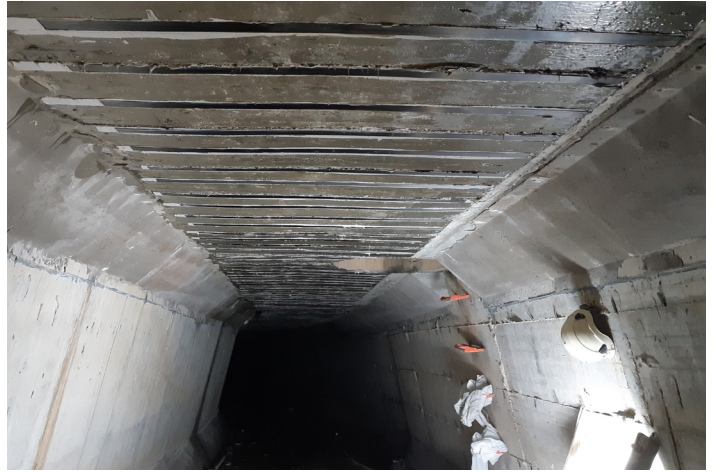
Sistema de refuerzo MasterBrace LAM aplicado
