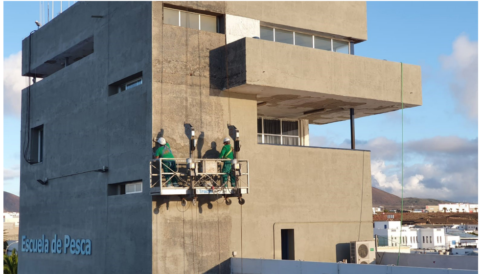
Vista de las fachadas del edificio intervenidas
