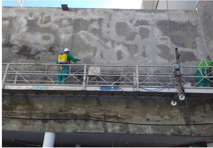
Reparación estructural, aplicación del inhibidor MasterProtect 8000 CI y acabado con MasterSeal 325 E
