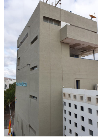
Reparación estructural, aplicación del inhibidor MasterProtect 8000 CI y acabado con MasterSeal 325 E
