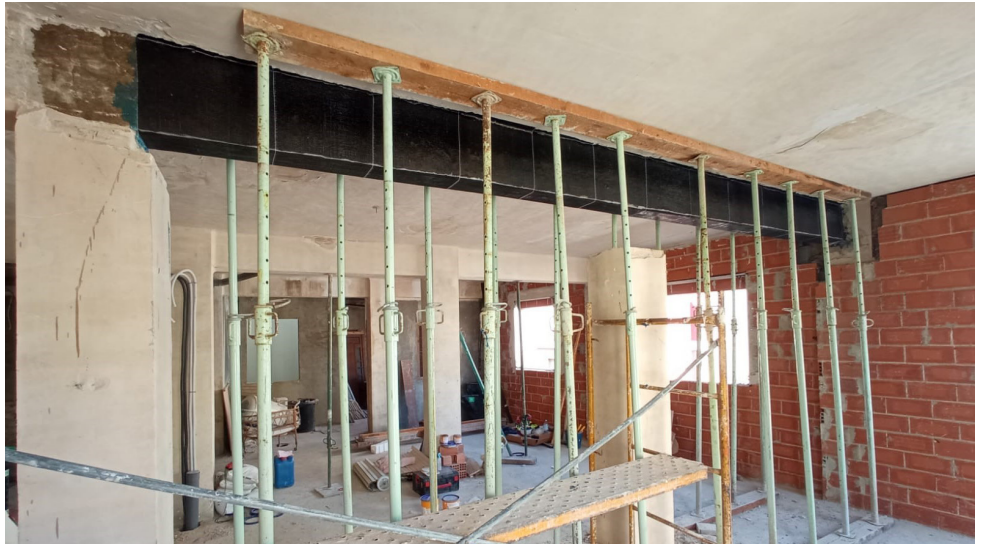
Refuerzo de viga con fibra de carbono MasterBrace
