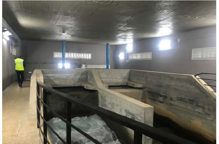
Acabado final de la zona de acceso
