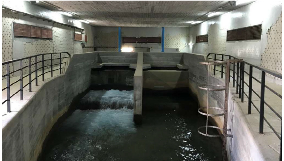
Vista interior del depósito
