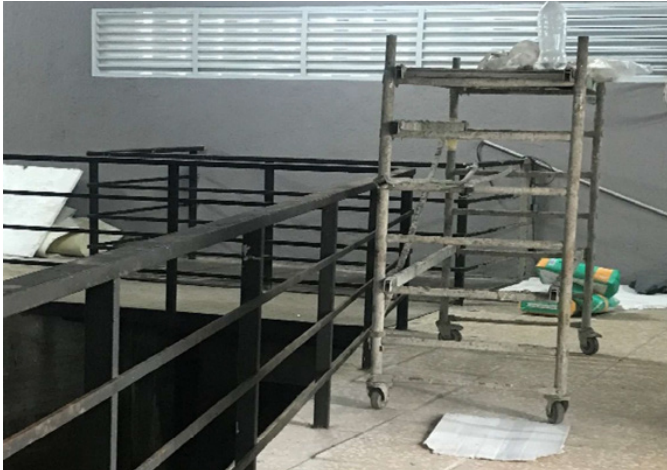
Reparación estructural e impermeabilización acabada recién pintada
